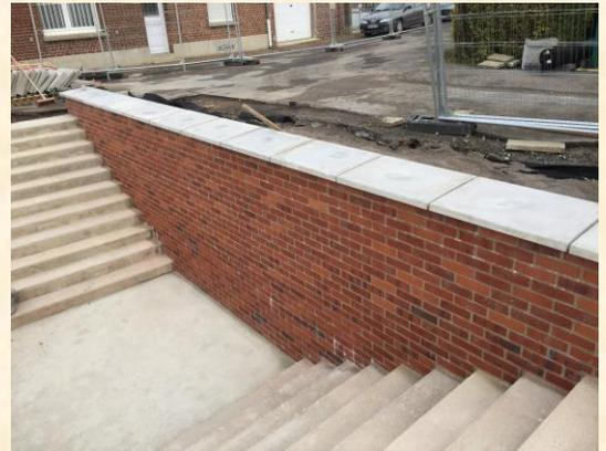
Ensuite un mur de briques est érigé agrafé au nouveau soutènement, Des petits détails de lignes Télécom sont également réglés avec Orange
